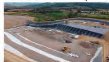
Interno impianto osmosi inversa
